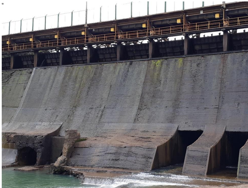
Figura 4 – Barragem a ser recuperada
