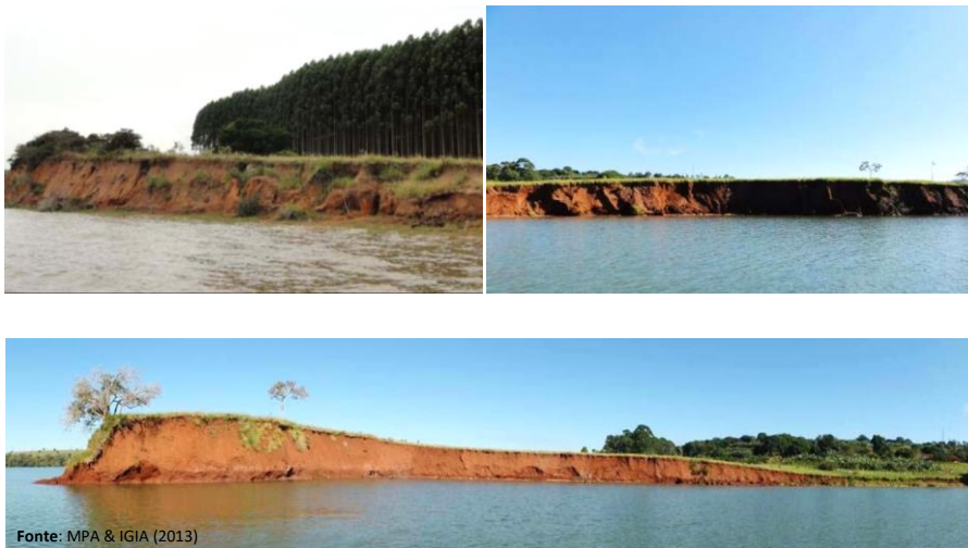
Figura 59 – Processos erosivos em margens de reservatórios do Paranapanema
