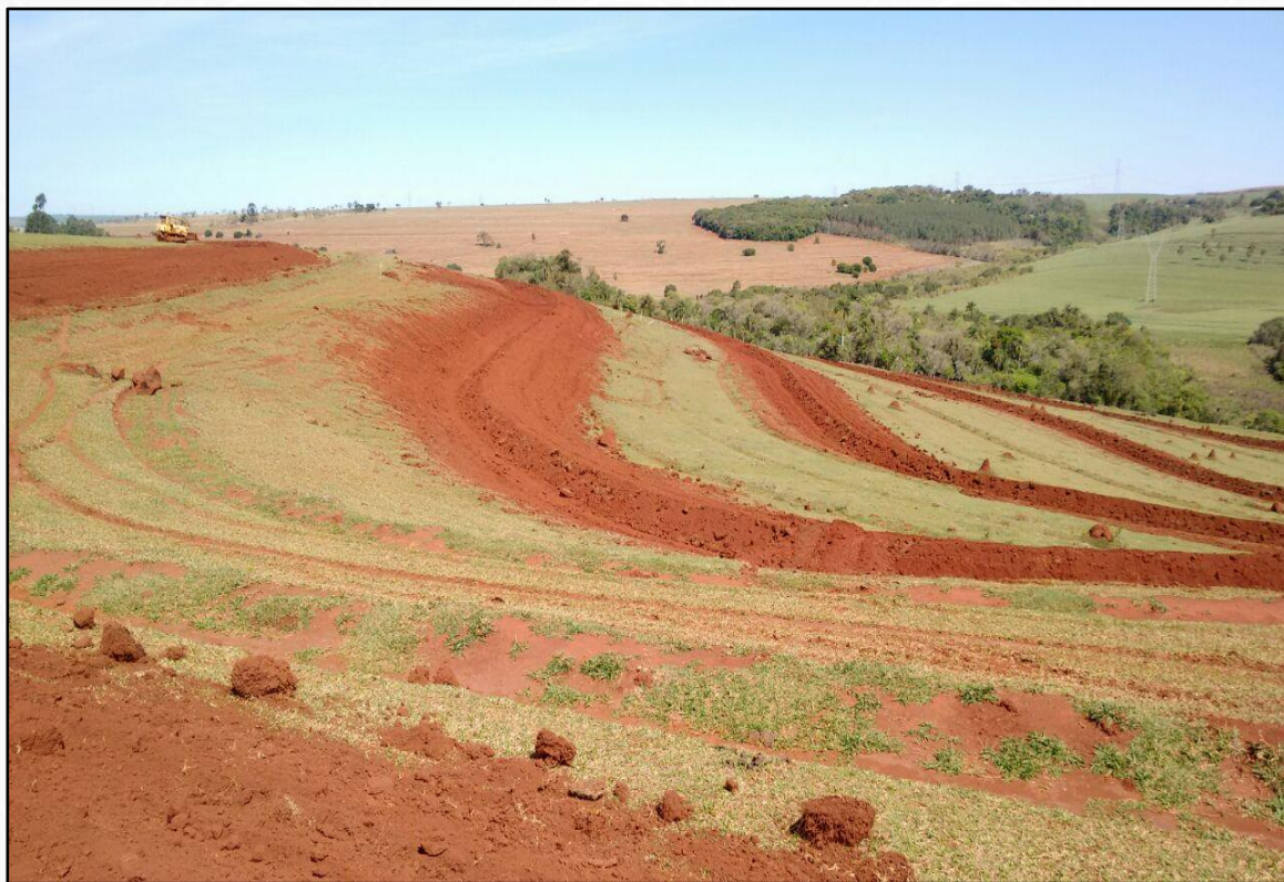
Construção de terraços
